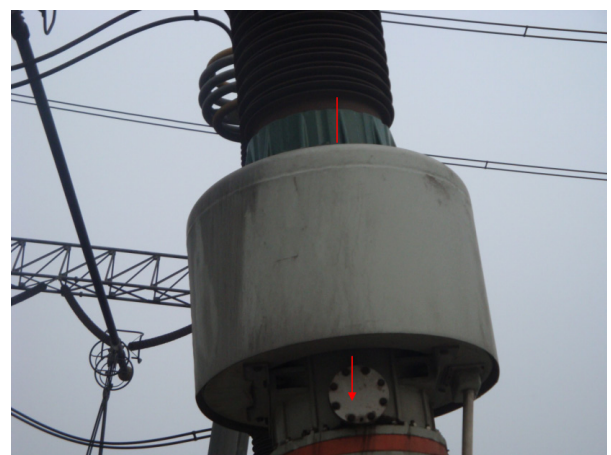
图 2 500kV 罐式开关点极性时电池线的穿入方法。
