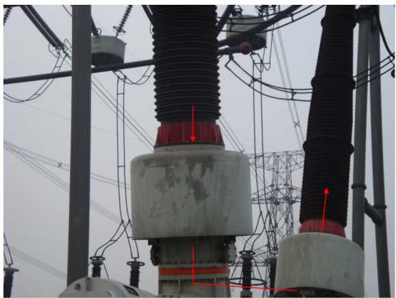
图4 也可以将点极性的线从两侧 CT 套中一贯而入。
