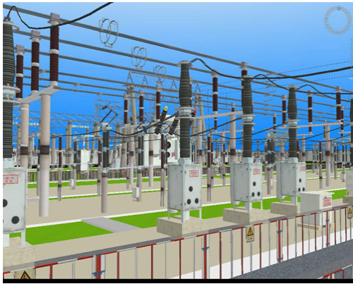
图 2 智能变电站 GIS 局部放电检测系统现场布设图
