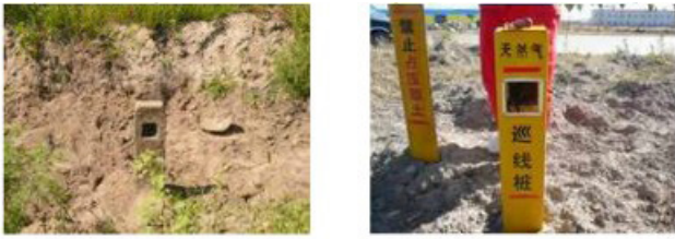
图3 混凝土测试桩和玻璃钢测试桩
