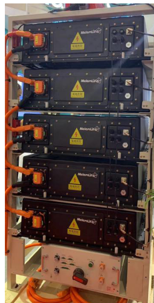
图1 电池仓及充电系统图
