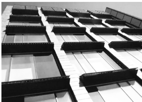
图2 应用太阳能的办公楼
