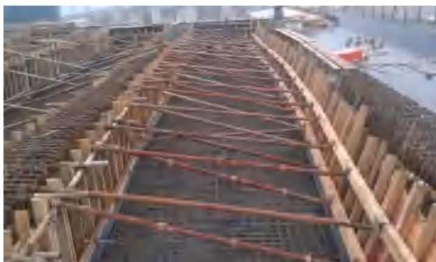
图1 现浇箱梁施工现场
