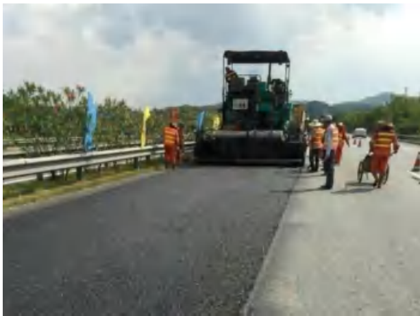
图1 超薄磨耗层施工
