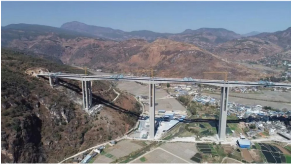
图1 公路桥梁过渡段
