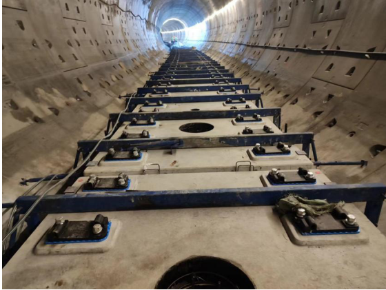
图4 预制板铺设、精调方向控制
