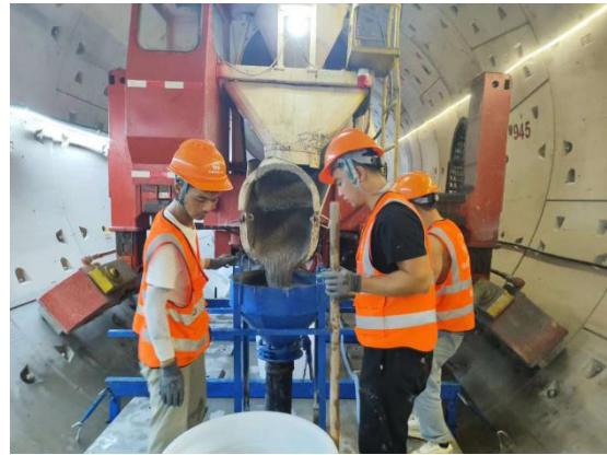
图5 板腔润湿、防溢管设置及自密实混凝土灌注
