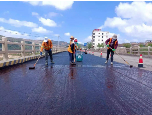
图1 沥青防水涂料施工
