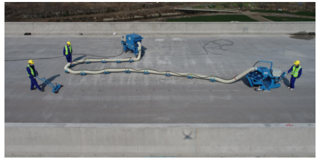
图2 抛丸施工
