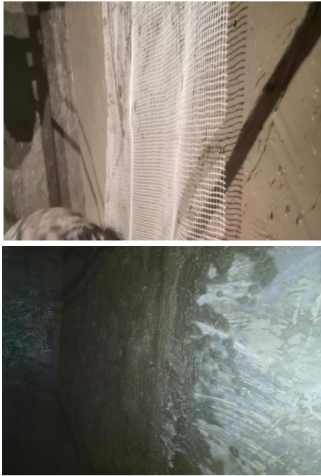
图 2 尼龙网加强层施工
