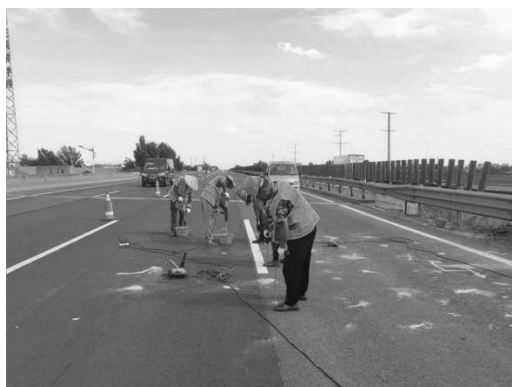
图一 某地地地下沉加固施工图
