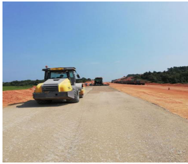
图2 路面垫层压实施工现场
