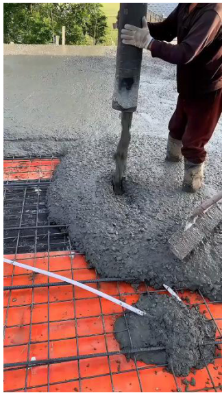
图1 混凝土浇筑示意图
