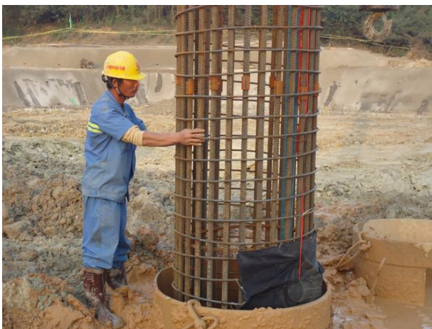
图1 桩基础施工技术
