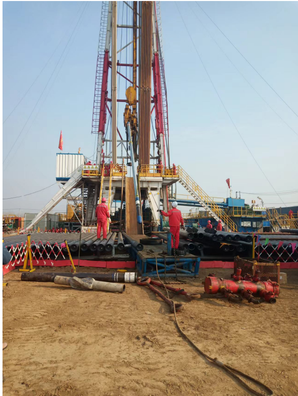
图1 盐穴储库初期建设情况
