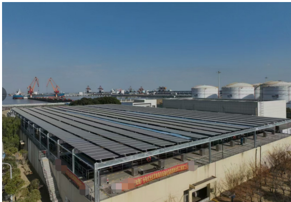
图1：光伏系统在污水厂处理池的应用
