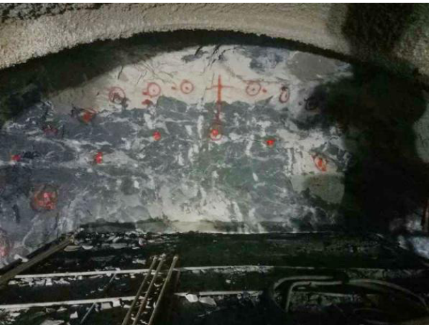
图4 精确测量炮眼
