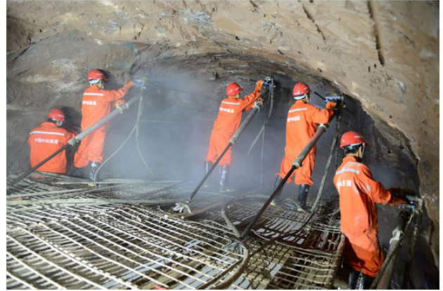
图5 严格控制钻眼精度
