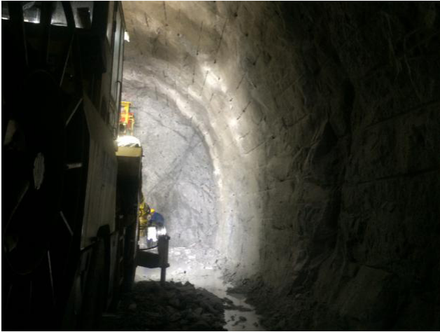
图6 正洞掌子面光爆效果图
