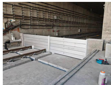
图 1 隧道洞口处定制安装防洪挡板
