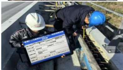
采用智慧标识牌进行隐蔽工程验收验证
