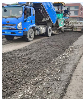
图1 道路施工中应用水泥稳定碎石材料
