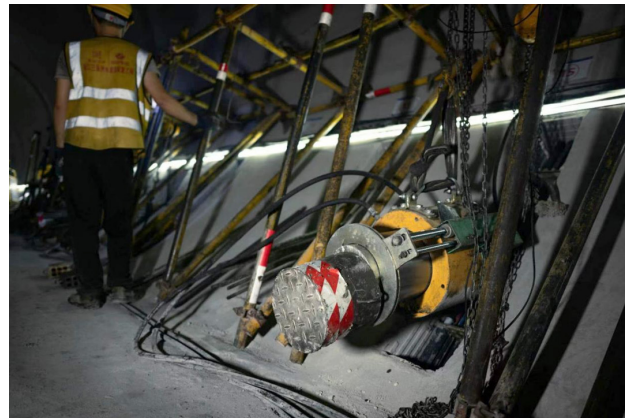
图 3-1 预应力钢绞线分级张拉
