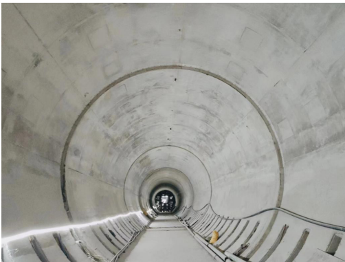
图 2-2 高强度预应力混凝土浇筑成型
