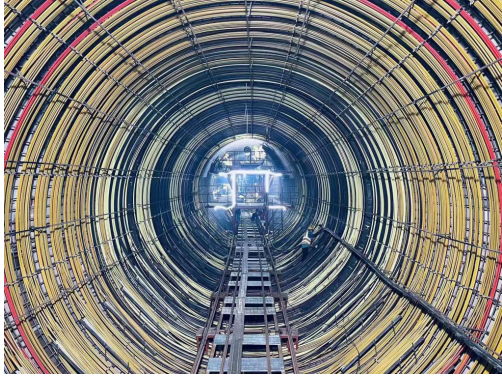
图 2-1 高强度预应力混凝土钢绞线安装
