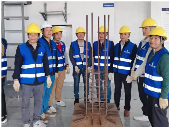
图2 施工人员培训现场
