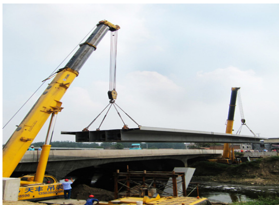
图1 分段吊装工艺
