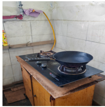
图三燃气灶具放置在可燃桌面上
