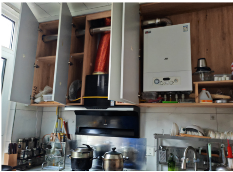
图八燃气用具设在密闭的橱柜内
