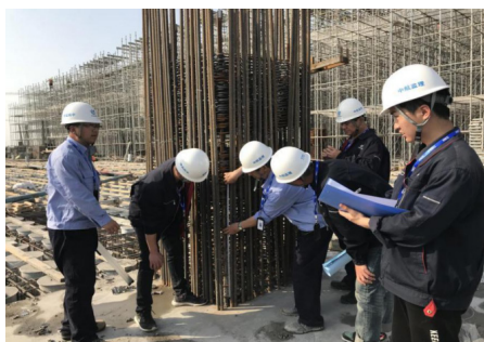
图1 房屋建筑工程监理
