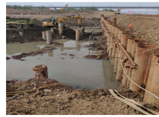
图 4-4 成型后支护和止水效果
