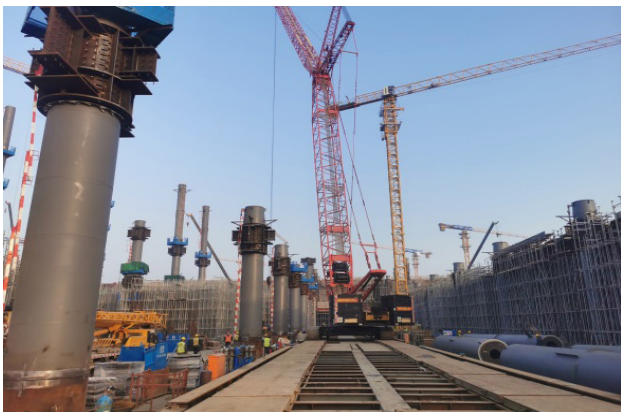
图 6 钢平台路基箱铺设示意
