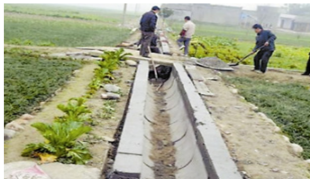
图1 水利设施检修
