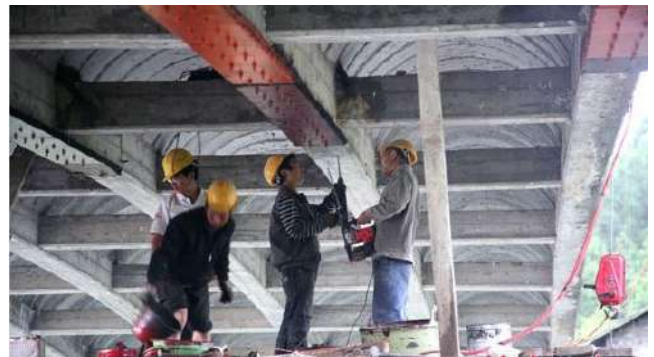
图1 粘贴钢板加固
