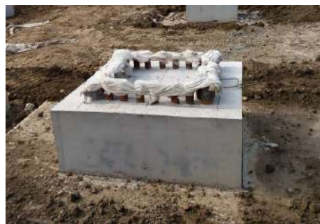
图 3 基础施工照片
