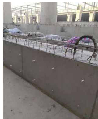
图 8 梁浇筑完成照片
