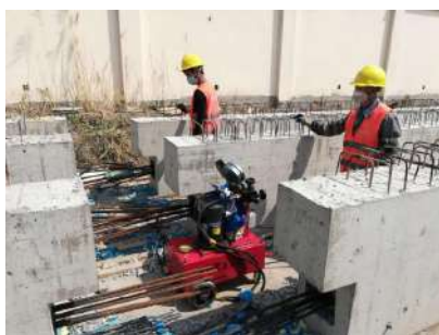
图 9 预应力梁张拉照片
