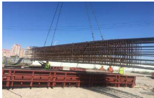
图 4 柱钢筋照片
