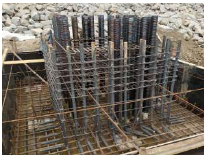
图 2 波纹钢管施工照片
