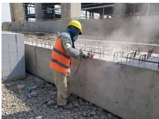
图 13 混凝土梁打磨照片
