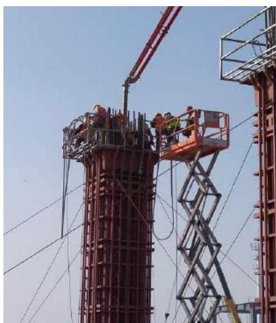
图 5 平台柱施工照片
