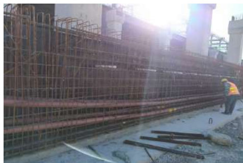
图 6 预应力梁钢筋绑扎照片
