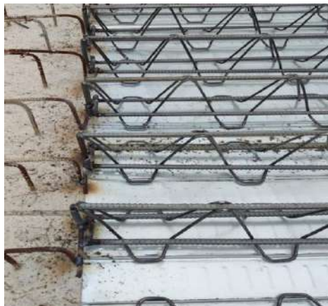
图 14 楼承板连接照片
