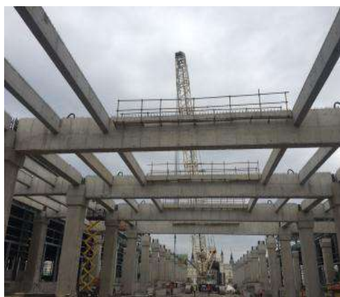
图 11 预应力梁吊装照片
