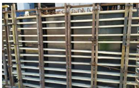
图 7 预应力梁模板照片
