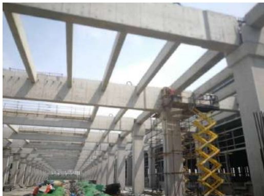
图 12 梁柱节点施工照片
