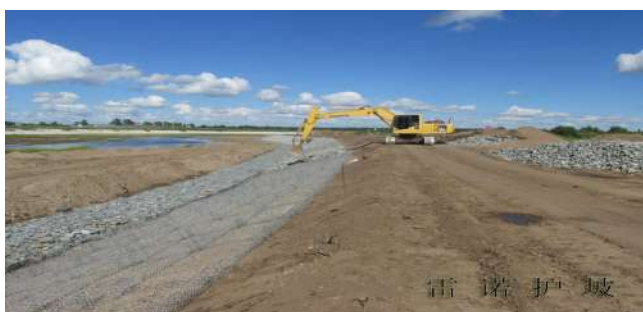
图2 石料填充施工图
