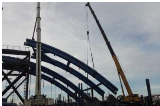
图10 拱肋的拼接（端段）
