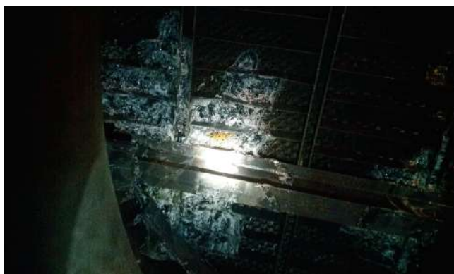
图2 苯乙烯装置精馏塔填料层聚合物
