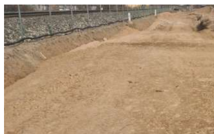
图 1 压实后的 A 组非冻胀填料
