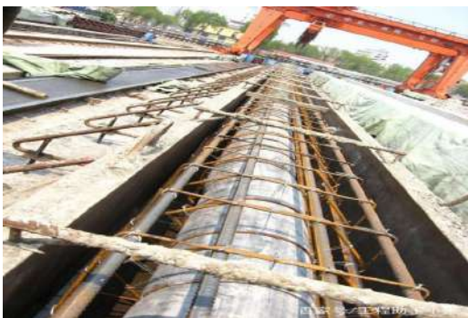
图 2 砼空心板的浇筑
