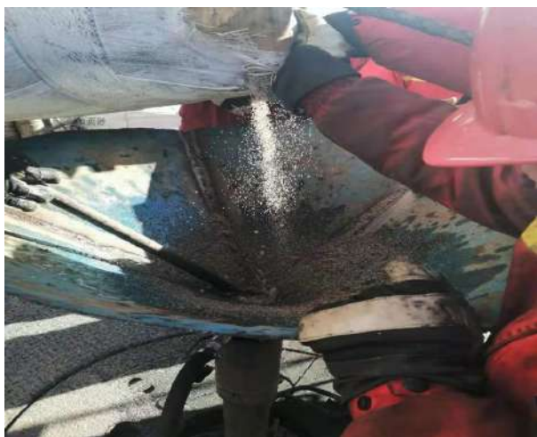
图 1 福 1X1 现场填砂施工作业
