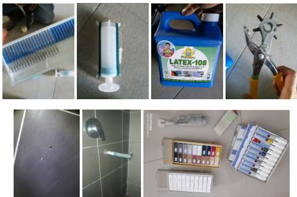
图2 瓷砖注浆修补工艺
