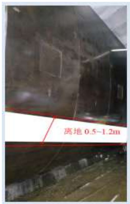
图 5 钢模台车及高分子透水布示意图
