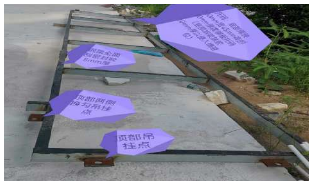
图3 吊挂玻璃钢架制作示意图
