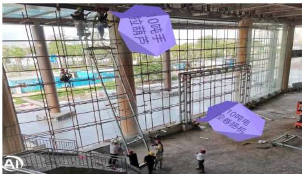
图4 玻璃吊装过程
