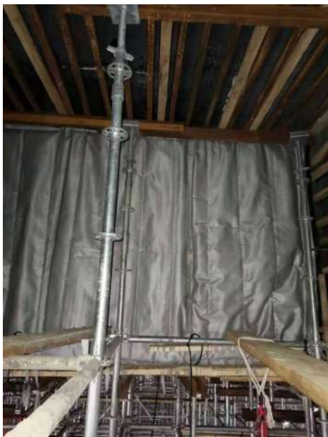
图4 梁侧热敷设膜铺设
