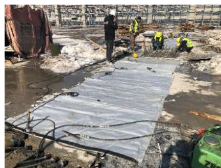
图 3 梁顶热敷膜铺设
