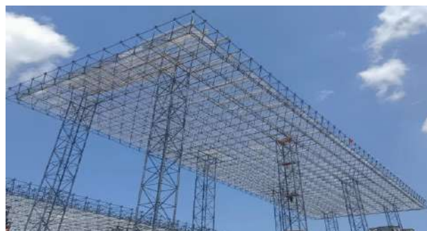
图2 整体顶升安装完成图
