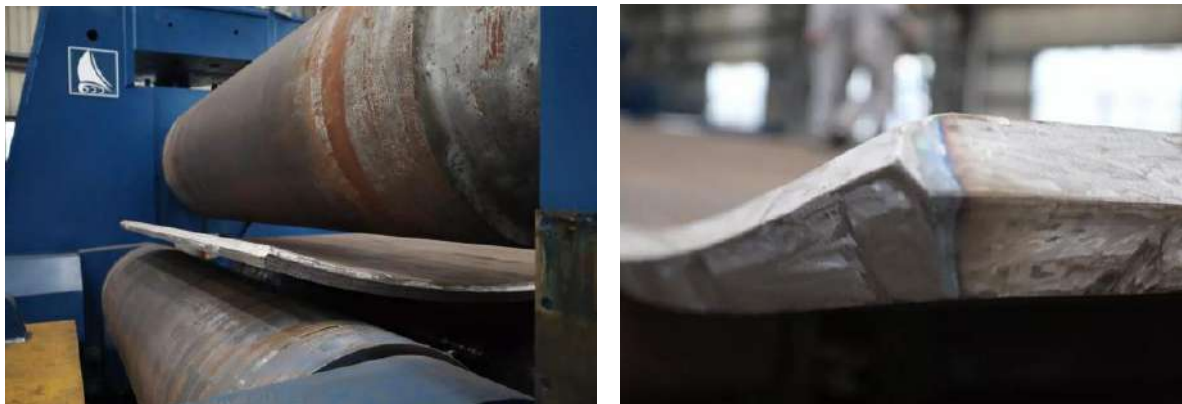
图2 筒体对接焊接预制坡口类型
