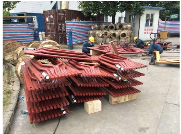
图2 现场文明施工
