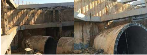
图 5 咬合桩切割开挖图
