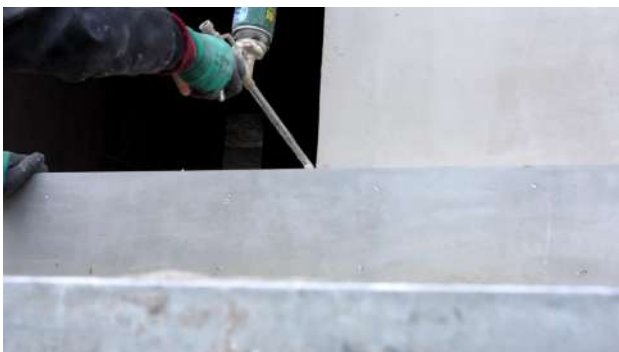
图8 打密封胶封闭
