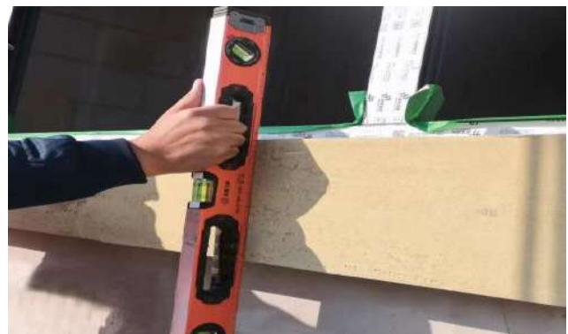
图 5 装饰线条临时固定后进行自检
