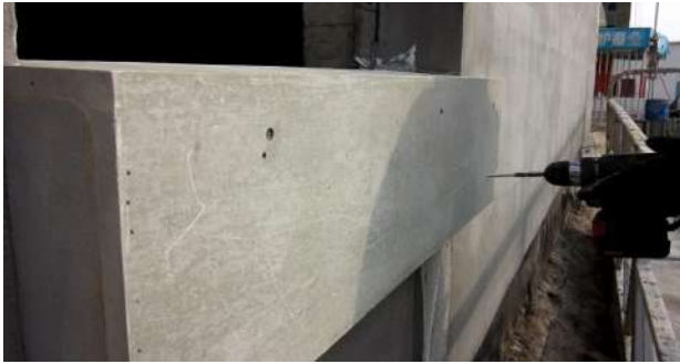
图6 装饰线条与方管固定
