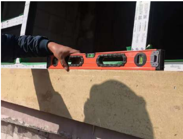
图7 装饰线条安装完成后进行自检
