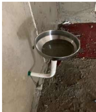
图2 L型注浆回流器
