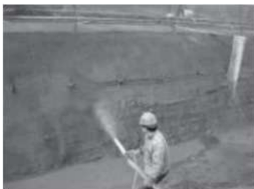
图1 喷射混凝土支护
