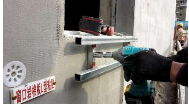
图 3 连接件固定
