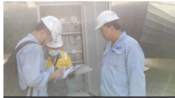
图2 印尼AWAR2×350MW燃煤火力发电厂吹管试验工作现场
