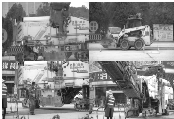
图2 公路施工现场作业
