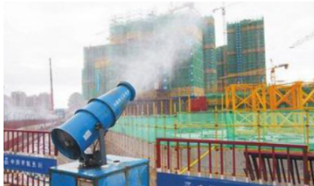
图2：某工程扬尘污染控制技术
