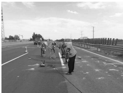
图一 某地地地下沉加固施工图
