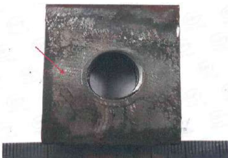
图 5 断裂残件表面宏观样貌
