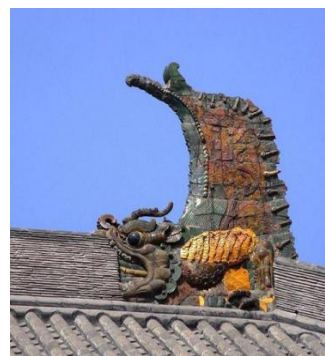
图1 古建筑避雷装置鸱吻
