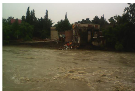
毗河 23+000-23+050 三河花园村河垮塌
