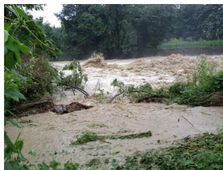
走马河羊子口电站脱水区右岸堤岸冲毁约1300米
