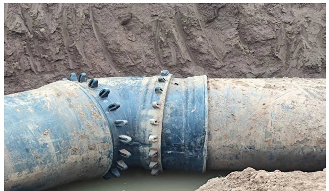
图 4: 78 度弯头组装示意
