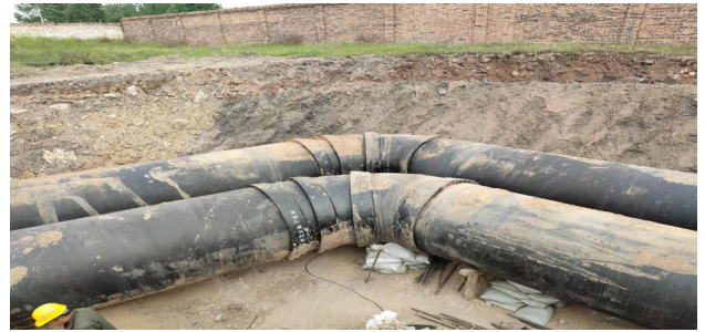
图 3: 双管道弯头组装示意
