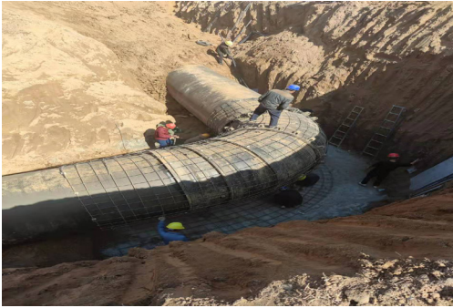
图5: 90度弯头组装示意
