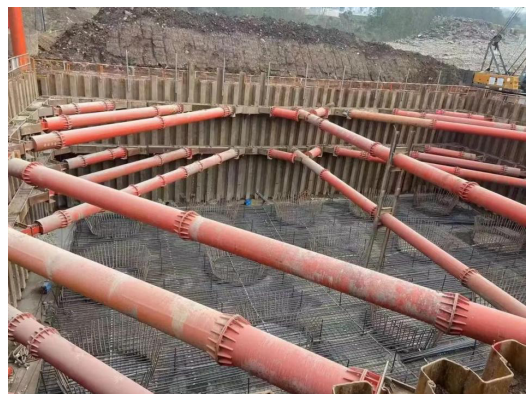
图1 钢板桩支护
