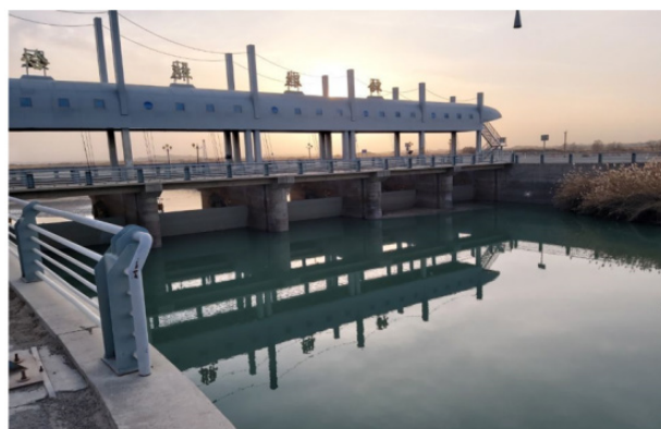
图4 恰拉枢纽实景图
