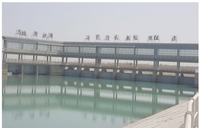
图1 乌斯满枢纽实景图
